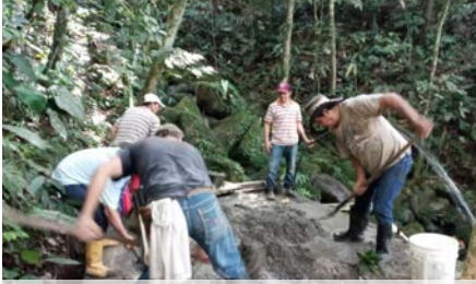
Reparación del tanque que abastece agua a familias de la vereda La Linda
